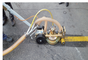
<그림 9> Marker Removing Equipment
